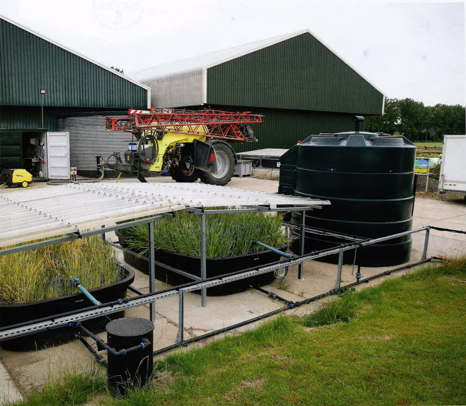
Een moderne wasplaats met opvang voor restvloeistoffen kan de erfemissie fors beperken, maar het vergt wel een flinke investering.
